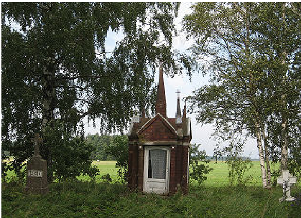
Koplyčia pastatyta Pavasarininkų draugijos 1939 m. vietoj nugriuvusios senosios koplyčios. V. Gembutienės nuotr. 2007 m.
